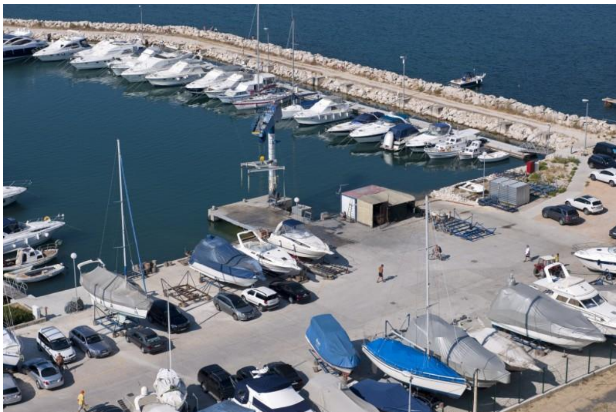
Slika 1.1.2.-1. Lukobran, gat A, dizalica i suhi vezovi ( www.aci-marinas.com )
